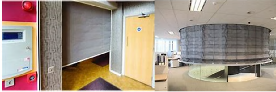
الشكل 3: حواجز الحرائق التلقائية
